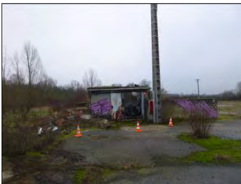
Figure 5 : Signalisation lors des interventions d'une zone contaminée par des débris de fibrociment
